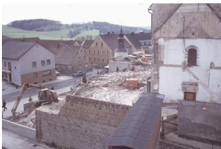
Beim Kirchenneubau 1976 (Georg Sauber)
