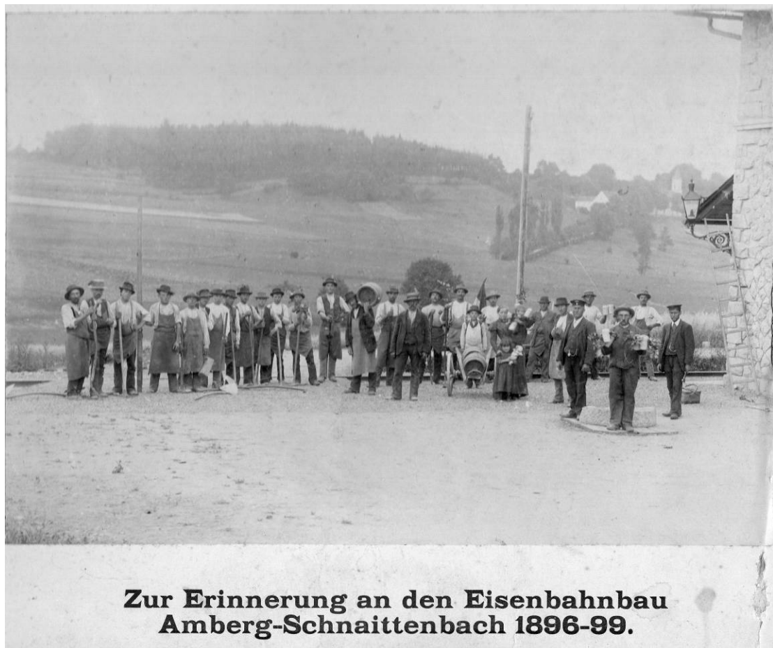
Bild mit Arbeitern 1898. Rechts ist der Bahnhof mit einer schmiedeeisernen Laterne zu erkennen.
