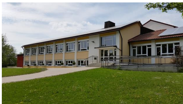
Schulgebäude von 1959 nach der Sanierung
