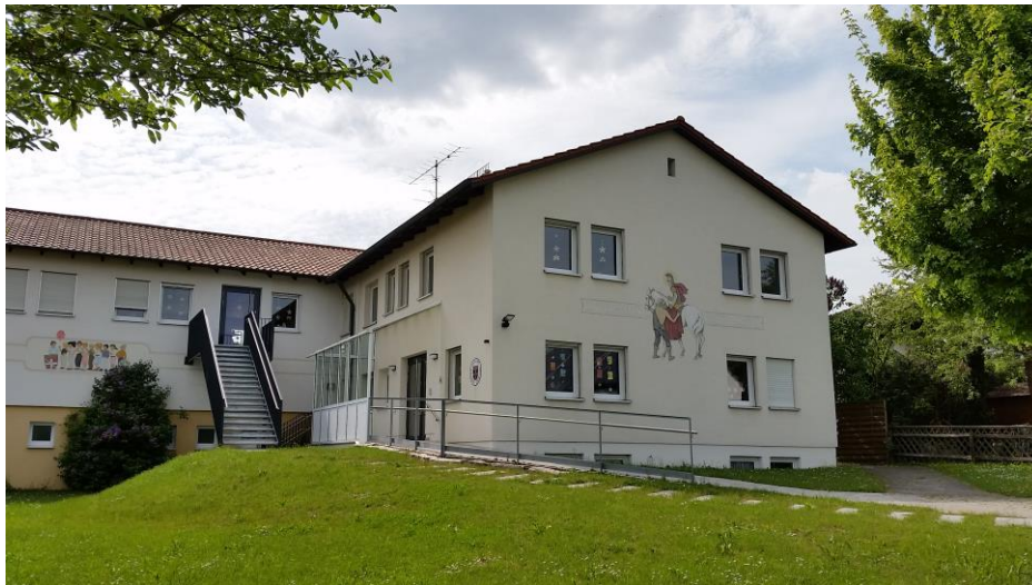
Ehemaliges Lehrerwohnhaus (1961), seit 1992 Kindergarten. Die Pausenhalle wurde 1994 aufgestockt, um Raum für eine zweite Kindergartengruppe zu erhalten.
