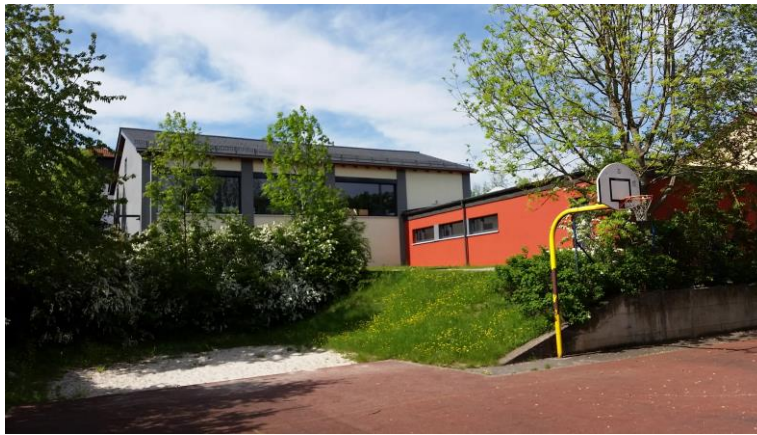
Mehrzweckhalle von 1976 nach der Sanierung
