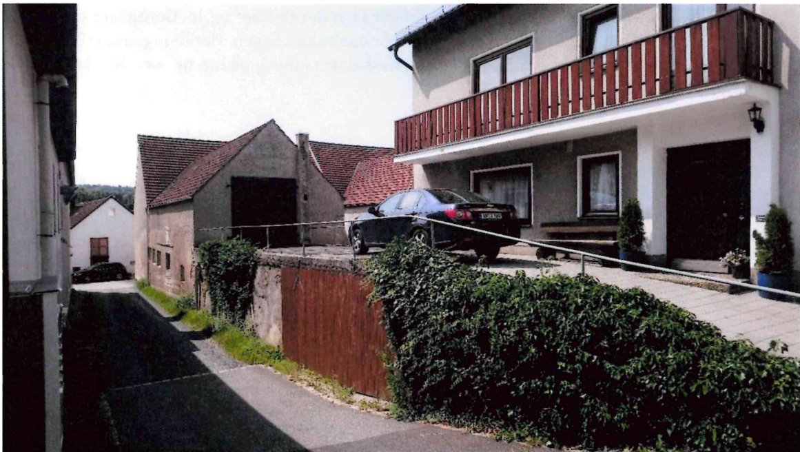
Abbildung 24: Wohn- und Wirtschaftsgebäude an der Hauptstraße, Gebenbach (Foto: IuM|St STADTSTRATEGIEN)
